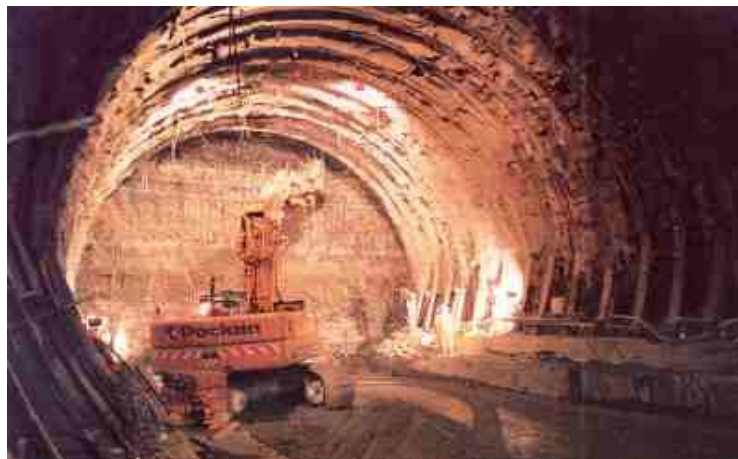
Figure I. 5 : Méthode à pleine section
