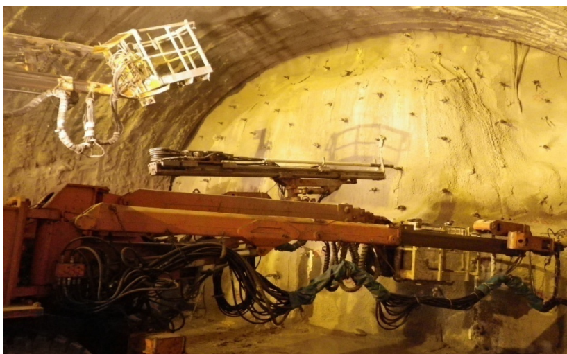
Figure. IV.6 : Pose de boulons en fibre de verre au front de taille.
