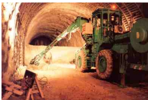
Figure I. 6 : Méthode de demi-section.
