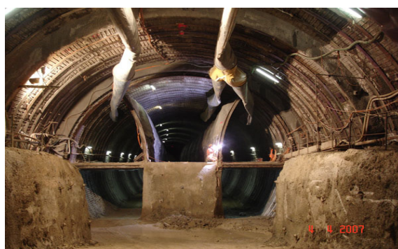
Figure I. 7 : Méthode de section divisée.
