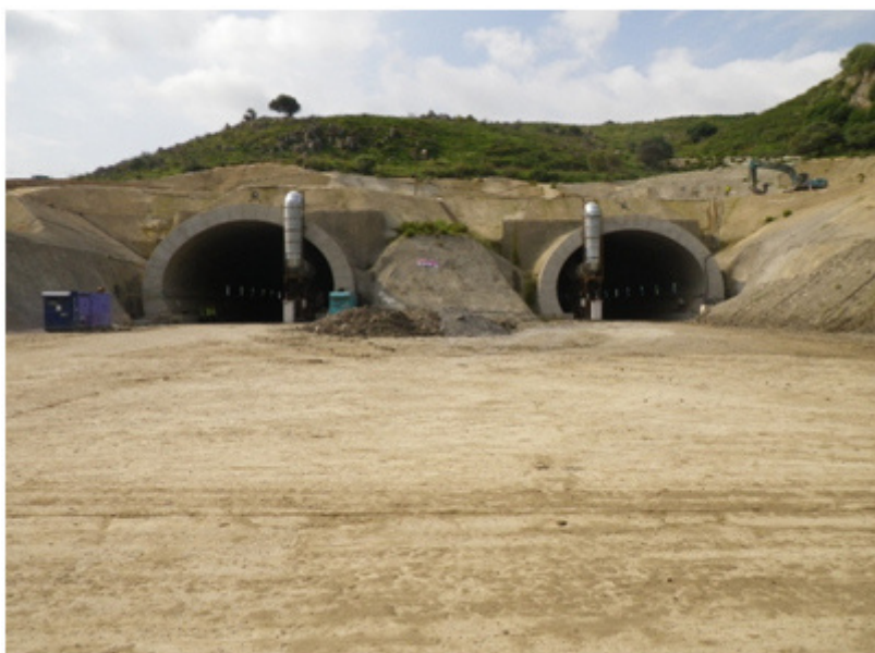
Figure V.1 : Portail sud de tunnels T4 (photo sur site)
