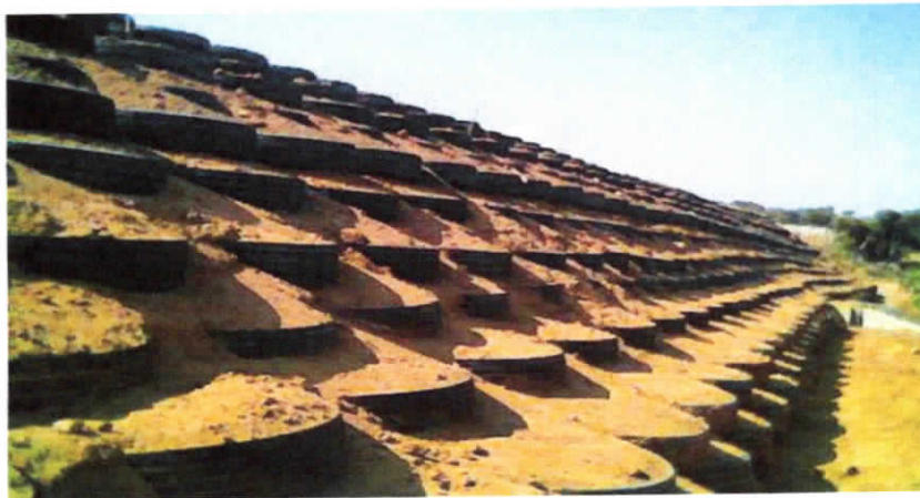
Figure (I.19) : Chantier expérimental Pneusol à Bou-Smail
