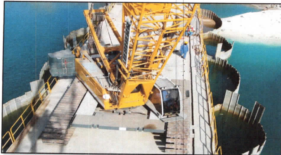
Figure I.10 : Quais en gabions de palplanches plates
