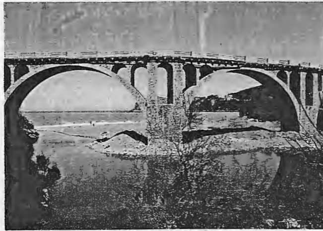
Figure n°29 : Pont de Dar El Oued
