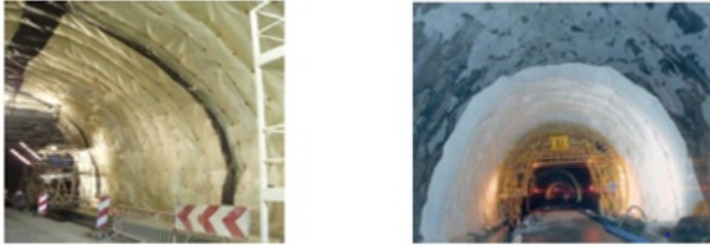
Figure .II.24 : Étanchéité d'un tunnel .
