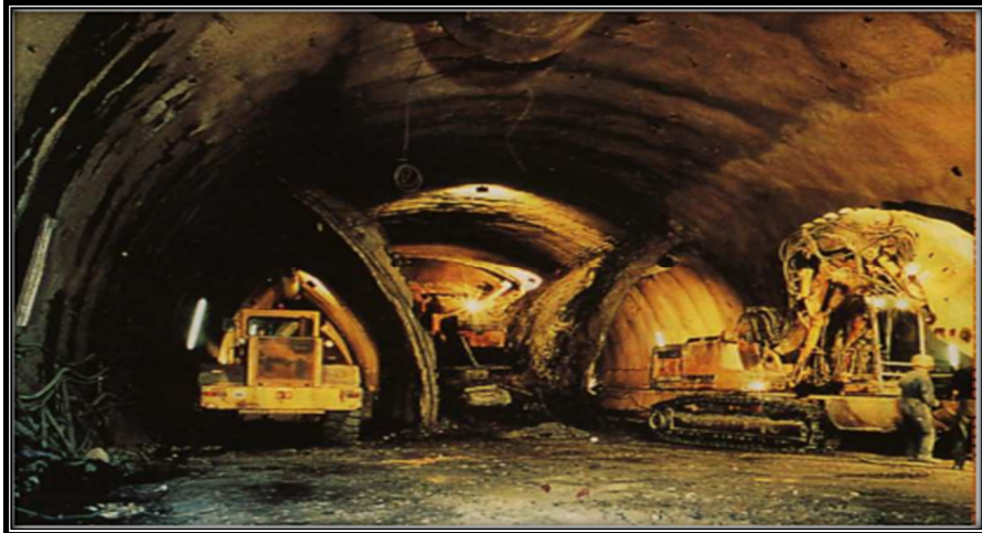
Figure.II.3 : Méthode de section divisée .
