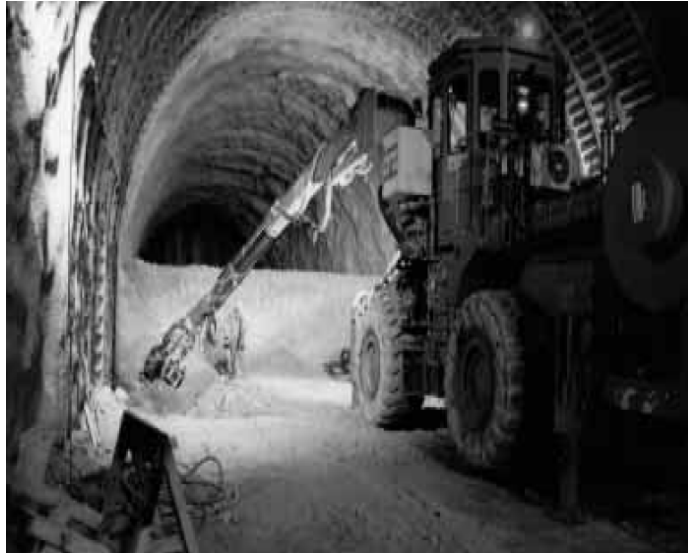
Figure. II.2 : creusement en demi-section .
