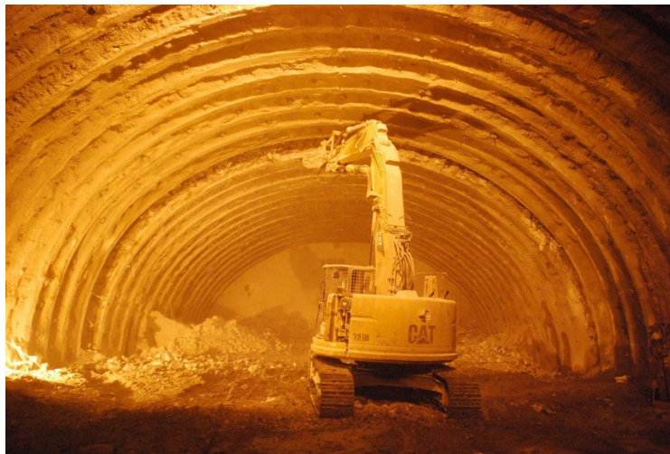
Figure. II.1 : creusement à pleine section
