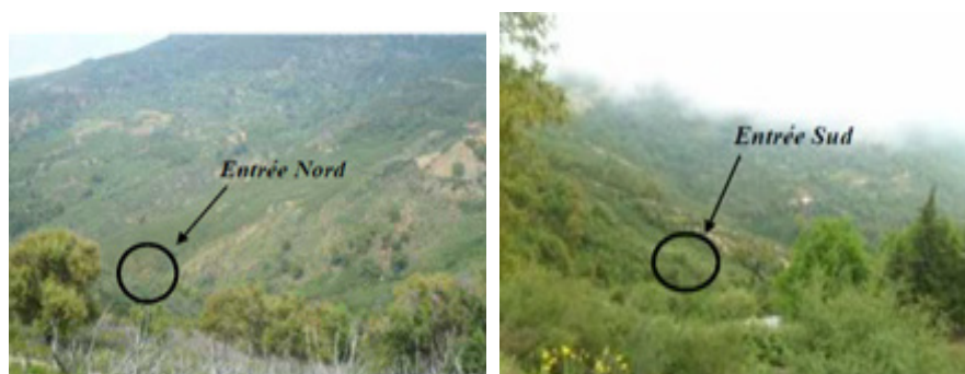
Figure V.2: Les deux entrées de Tunnel .
