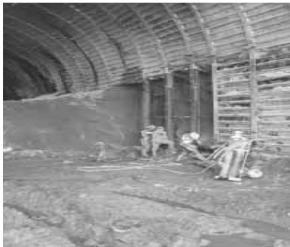
Figure. II.10 : soutènement par blindage.
