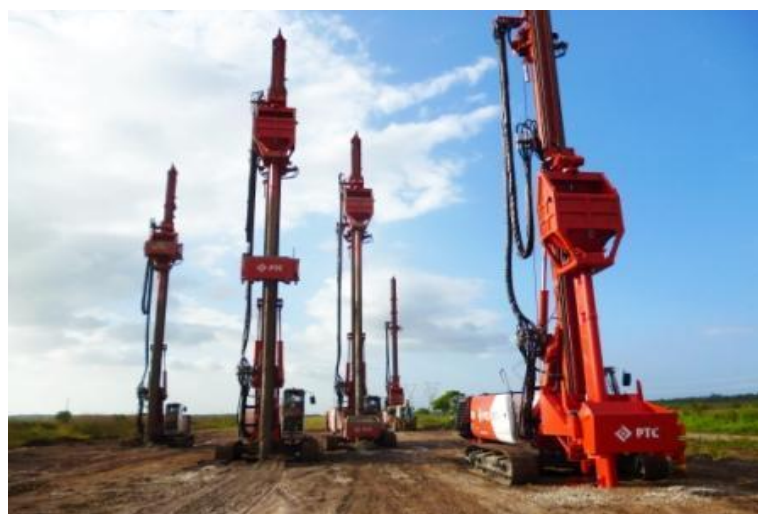
Figure I.36 les colonnes ballastées
