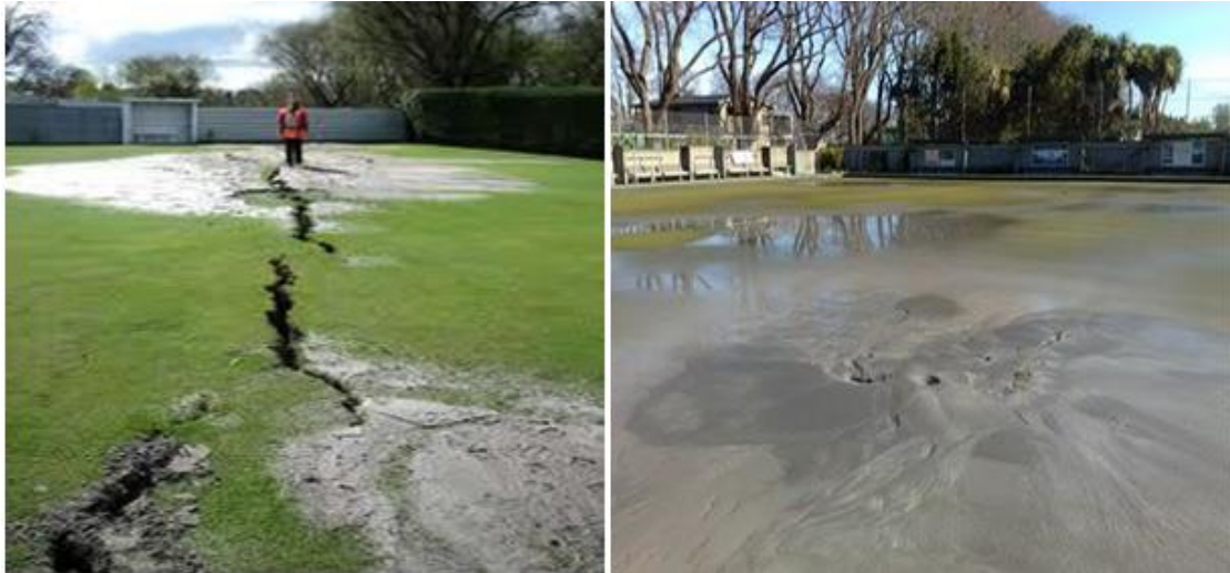
Figure I.25 Ebullitions de sable dues à la liquéfaction, après le tremblement de terre à Christchurch, New Zealand(2011).
