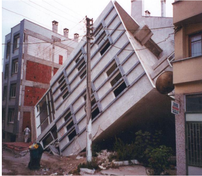
Figure I.19 Renversement d'une structure sous l'effet de la liquéfaction sismique Turquie 1999
