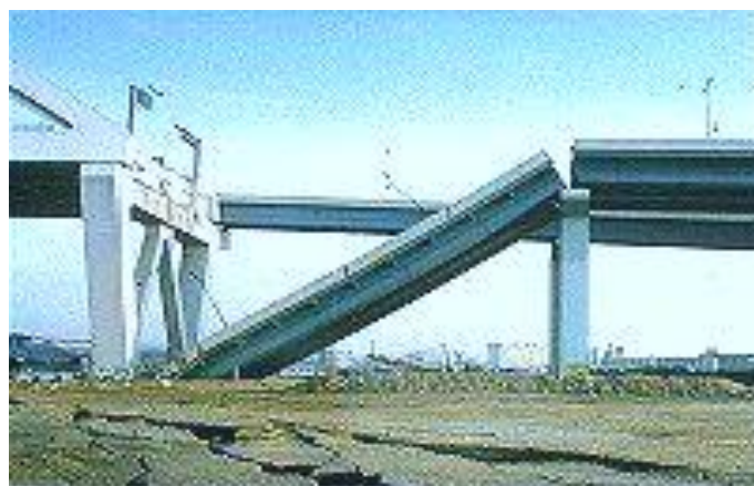
Figure I.9 Endommagement des ponts : Un tel dommage peut avoir des conséquences désastreuses, empêchant même les opérations de sauvetage. Les mouvements induits par la liquéfaction peuvent pousser les bases hors du point où le pont enjambe l'appui, dans ce cas le pont lâche
