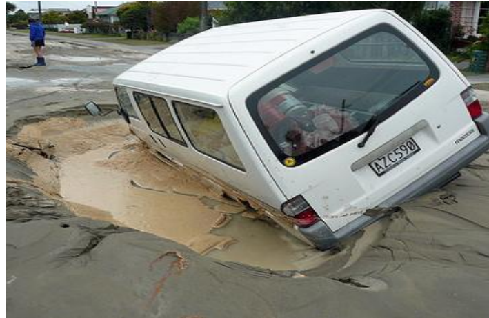
Figure I.23 Une camionnette qui malheureusement conduit dans un trou causé par la liquéfaction, du Nord de New Brighton, lors du séisme de Christchurch (2011)
