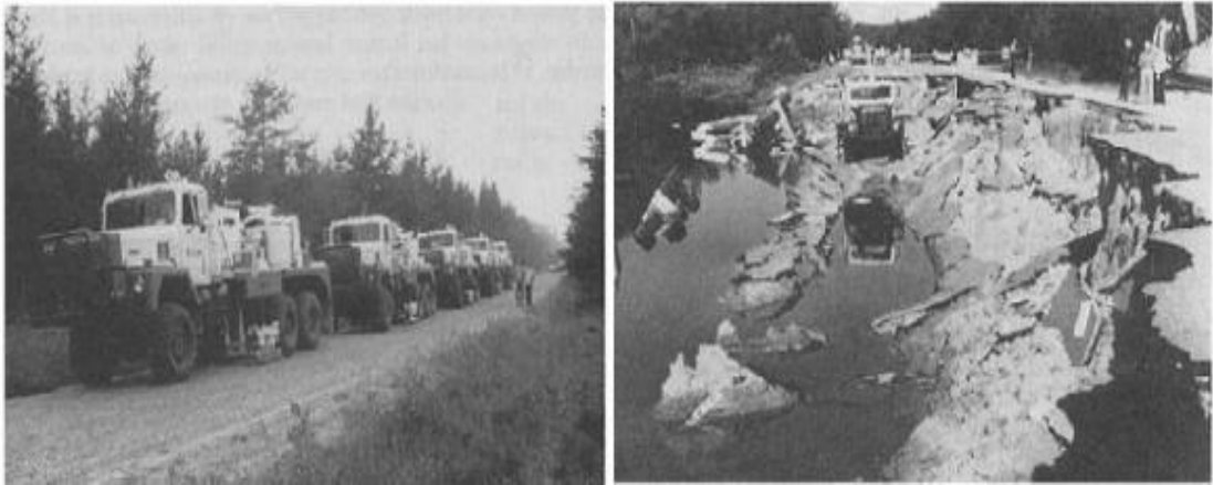
Figure I.5 rupture de remblai sur le lac Ackermann déclenché par camions de vibro-séisme
