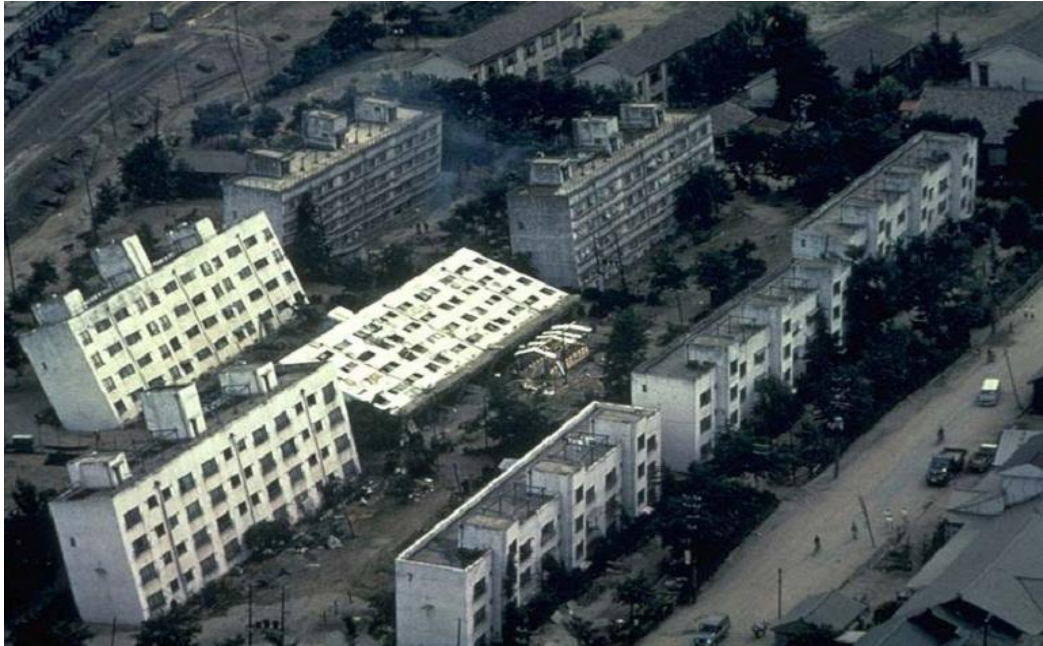
Figure I.3 Inclinaison des bâtiments d'appartements de Kawagishi-cho à Niigata au Japon dues à la Chute de la capacité portante du sol par liquéfaction [3]
