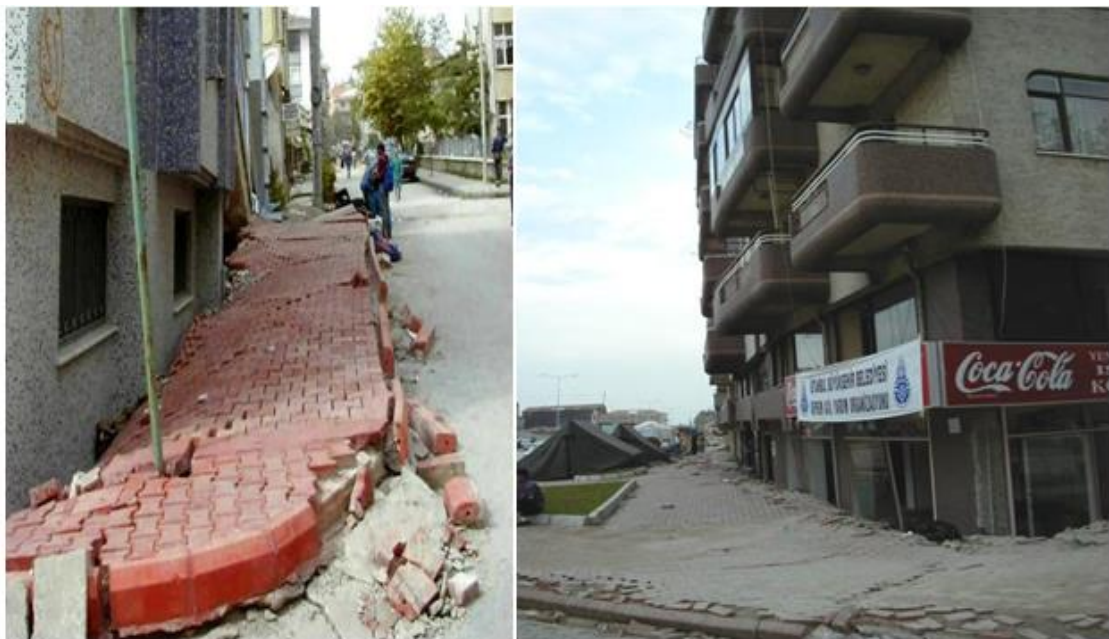
Figure I.18 Poinçonnement de la fondation sous la liquéfaction séisme Turquie 1999
