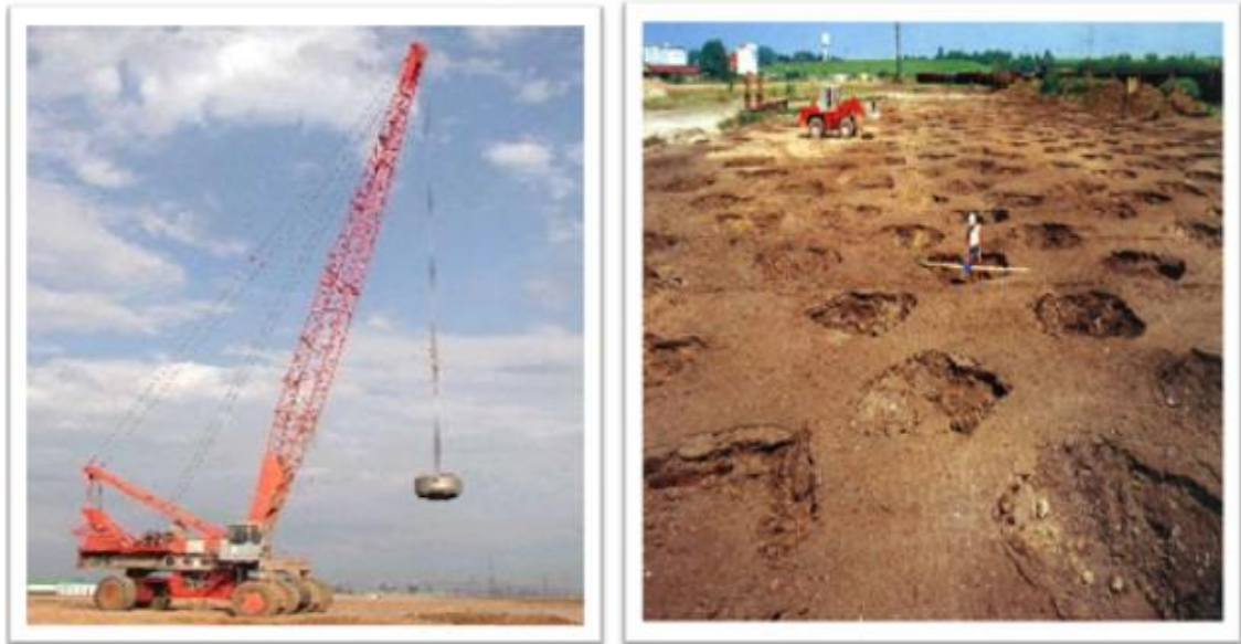
Figure I.39 Compactage dynamique
