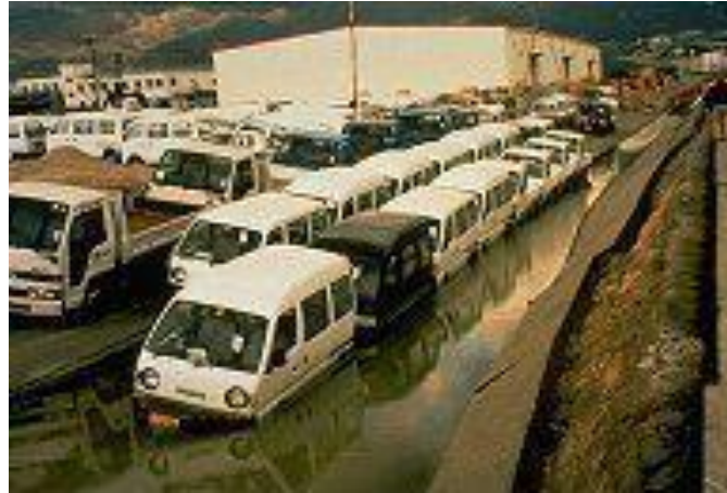
Figure I.10 Endommagement des routes : Baisse du niveau de la route due à l'épandage latéral
