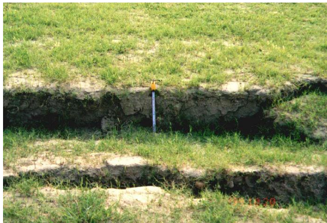
Figure I.13 Fissures considérables dans le sol à Nantou
