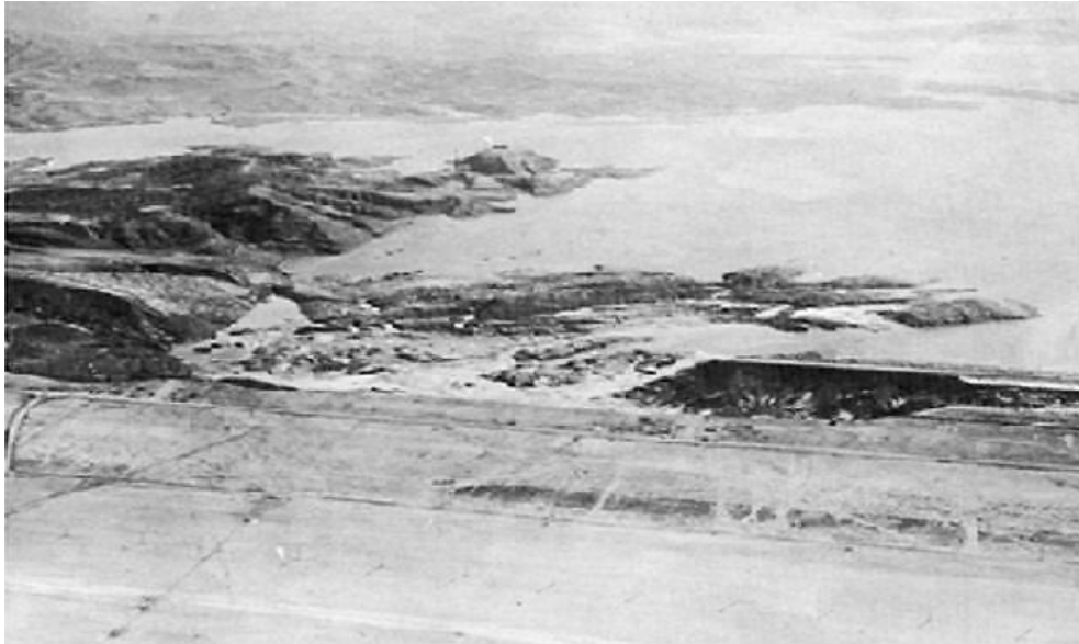
Figure I.2 vue aérienne de la rupture de barrage de Fort Peck [2]
