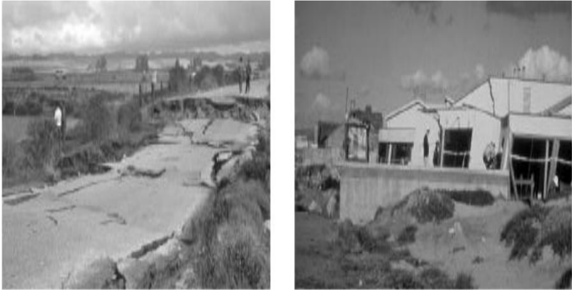
Figure I.7 Epanchage latéral le long de la route Sandholdt (à gauche) et destruction d'un centre de recherche (à droite) à Moss Landing.
