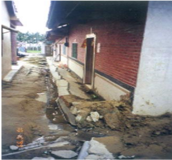
Figure I.12 Ebullition de sable dans un quartier résidentiel au Comté de Zhanghua
