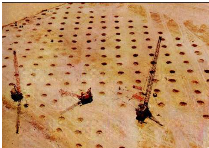
Figure I.9. Chantier de pilonnage.
