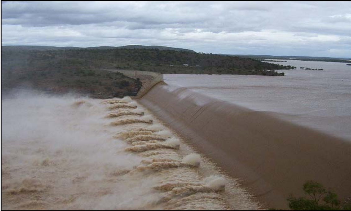
Figure 1.1 : Barrage de BURDEKIN en Australie, montrant un ressaut hydraulique prononcé induit par des obstructions en aval et un changement de gradient
