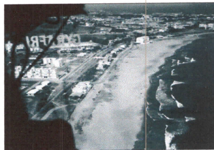
Figure 21 : Vue aérienne sur le site du projet (cité plage, ex Casino -Jijel-) vers 1960, Source: jijelnews.com
