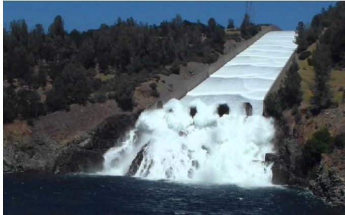
Figure (I.23) : Evacuateur de crue du barrage d'Oroville « Californie »
