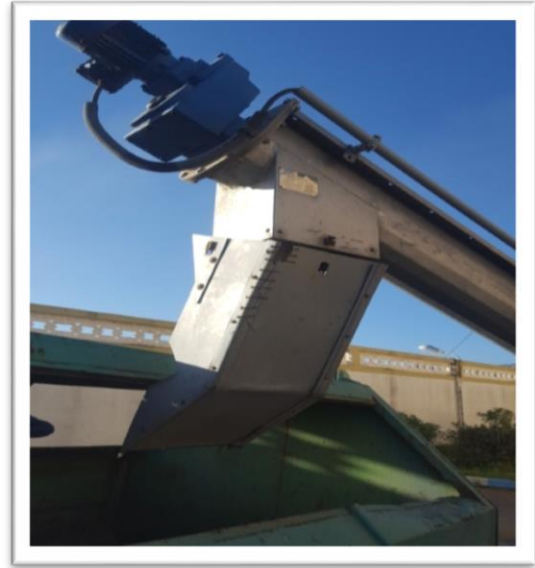
Photo 04 : Les déchets de dessablage (STEP de la ville de Jijel)
