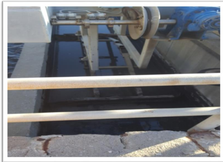
Photo 05 : Dégrossage (STEP de la ville de Jijel)
