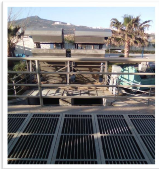
Photo 01 : Les deux grilles grossières (STEP de la ville de Jijel)
