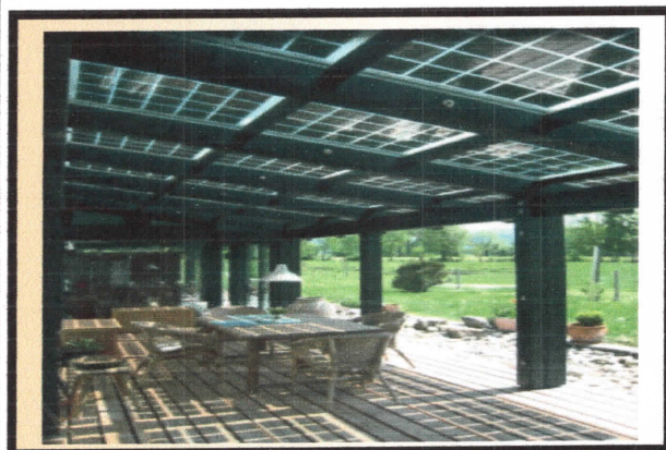
Figure 4 : Installations des panneaux photovoltaïques véranda source site internet
