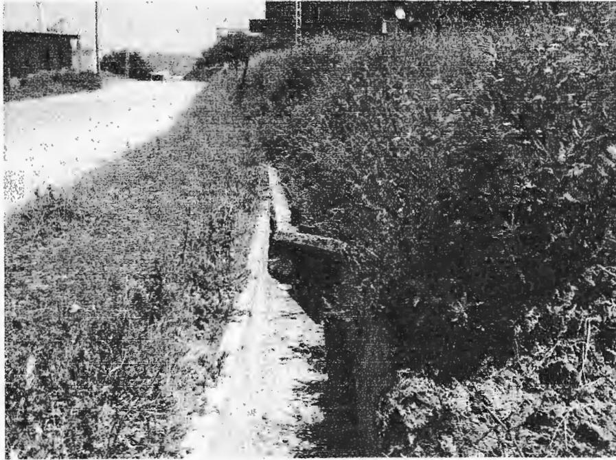
**Planche 4.16 :** Pincement du fossé bétonné suite à l'avancée du talus (Arrachement superficiel). (Photo prise le 08-06-2009)
