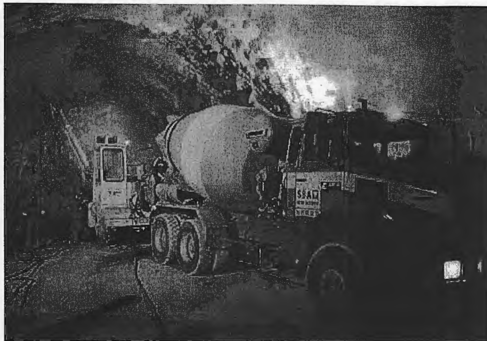
Figure15: Soutènement par béton projeté.
