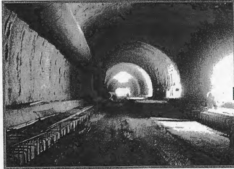
Figure 03 : Tunnel de Dar el oued
