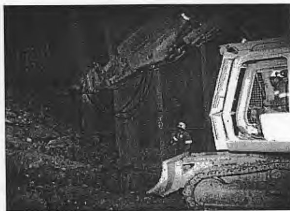
Figure13 : abattage par machine à attaque ponctuelle.
