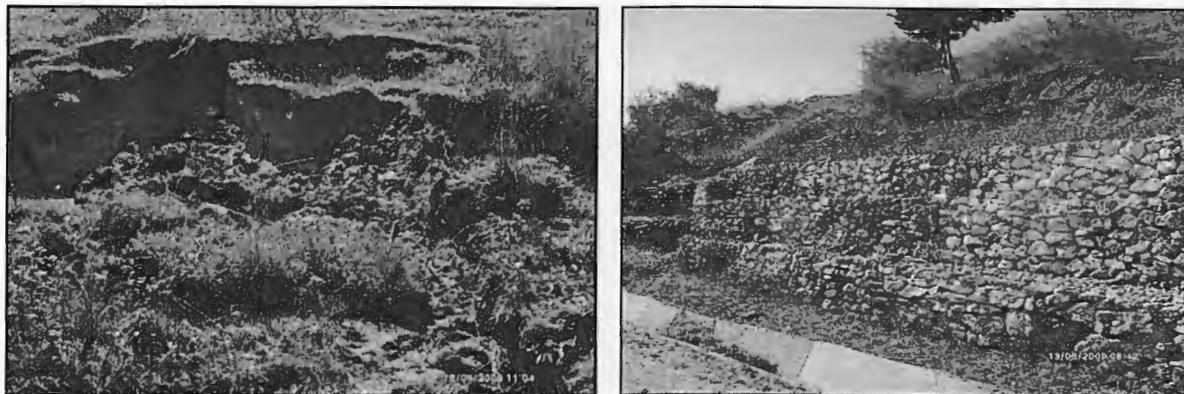
Photo (III-7) : Les indices d'instabilité sur le talus au niveau de la route RN43.
