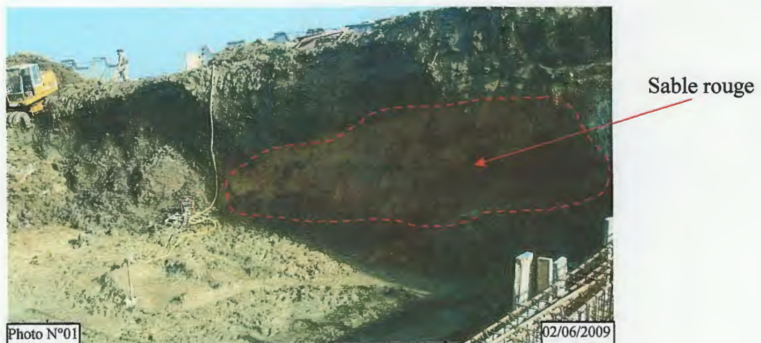
Photo N° 01 : Poche de sable rouge mis en évidence lors des travaux de terrassement
