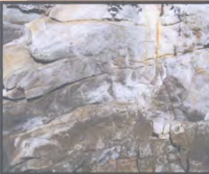
Photo.III.1 : La diversité de multi fracture au niveau de banc de grès.
