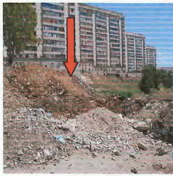
La présence de poids de déblai
