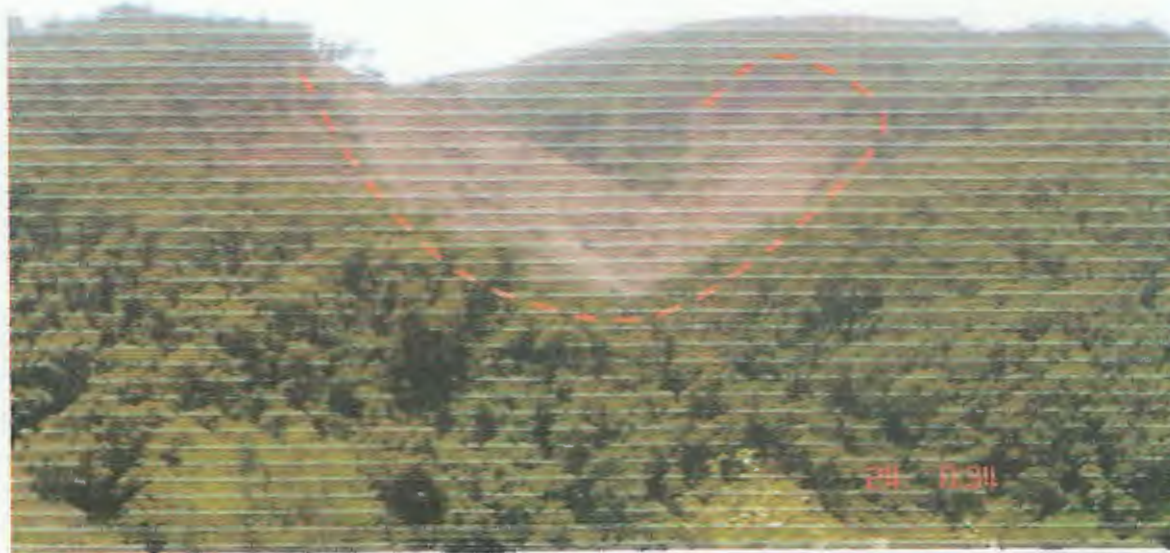
Fig (VI-12) : Photo illustrant une désagrégation sur le talus par l'effet de ruissellement.
