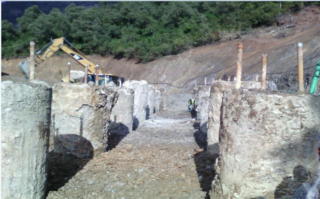
**Figure. V. 4 :** Photo illustrant un groupe de pieux au niveau de la pile N° 04 avant le recépage.
