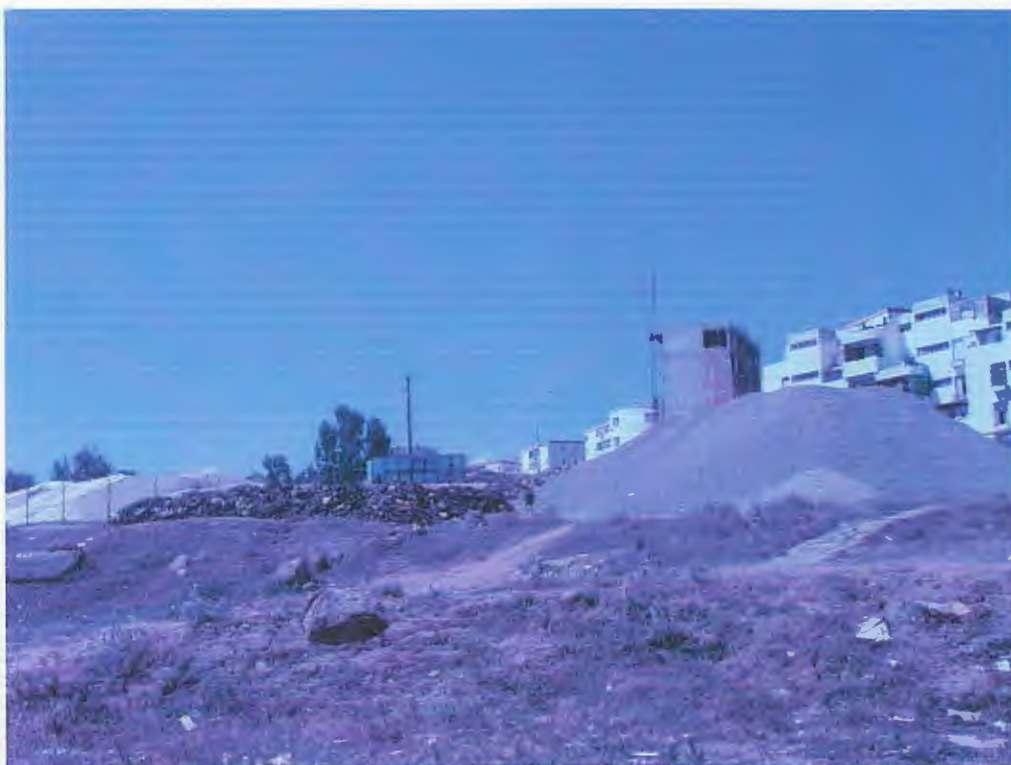
Photo.VI.2 : Présence d'un chantier. (Photo prise le 27-06-2005).
