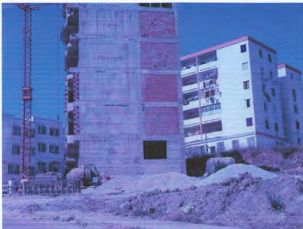
Photo.VI.3 : Nouveau bâtiment de type R+5. (Photo prise le 27-06-2005).
