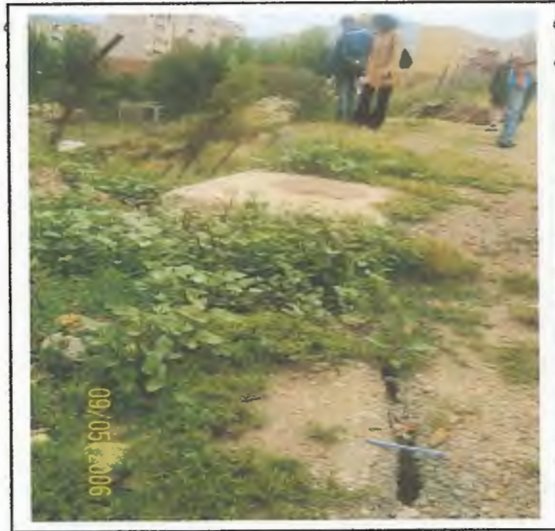
Fissure indiquant le déclanchement du glissement.
