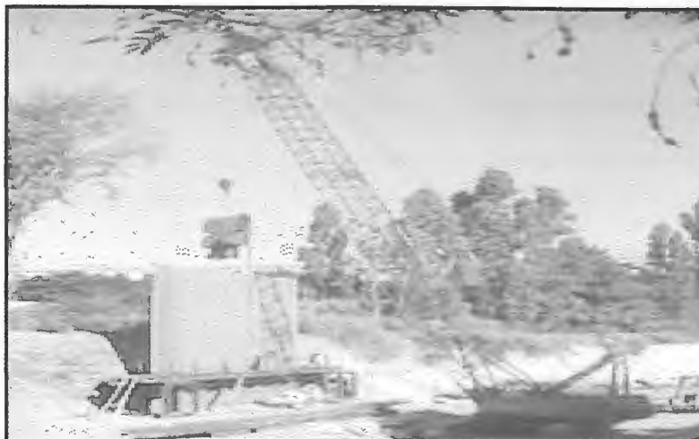
Fig-VIII-5 : Implantation d'un rideau de palplanches.
