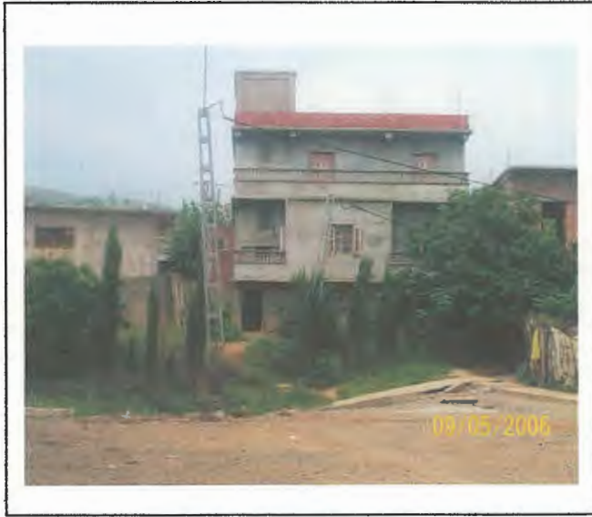
Manque des poteaux électriques
