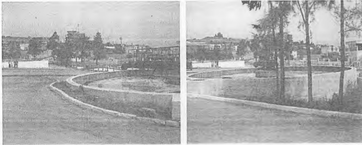
Figure 3: Vue de la station d'épuration.
