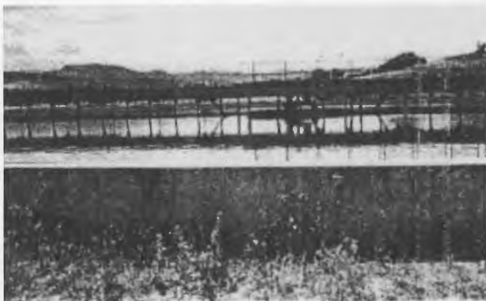
Figure 14. Bassin de décantation.
