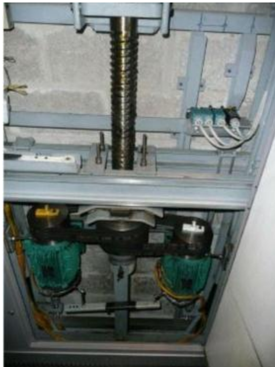
Figure 1.8 : Mécanisme d'un ascenseur à vis
